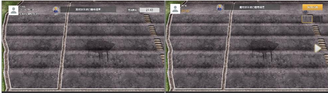
7) 上图为出现渗漏异常情况。考点：坝体渗漏。
