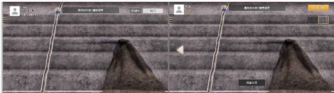
6) 上图为出现滑坡异常情况。考点：坝体滑坡
